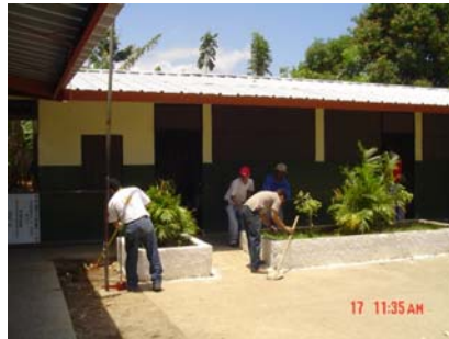
Trabajos de mejoras en La Ceiba.
