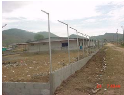
Construcción de cerco de Escuela Harry Thomas en Villanueva (Antes)
