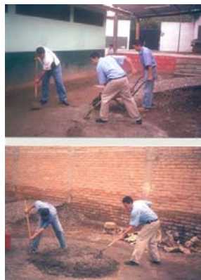
Trabajos de mejoras en Tegucigalpa
