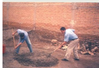
Trabajos de mejoras en Tegucigalpa
