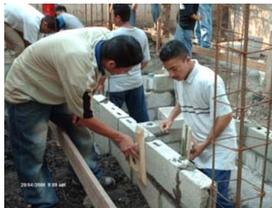
Construcción de Sanitarios en Escuela Minerva de Dos Caminos
