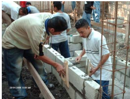
Construcción de Sanitarios en Escuela Minerva de Dos Caminos
